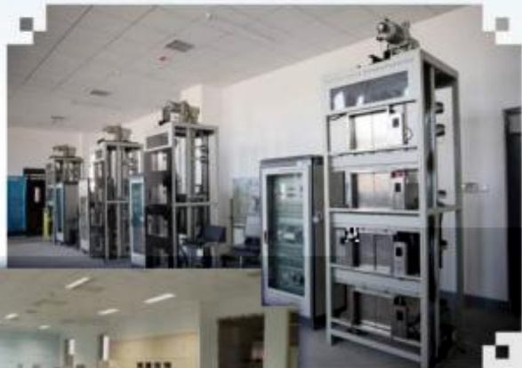
智能电梯安装调试 维护训练场所
